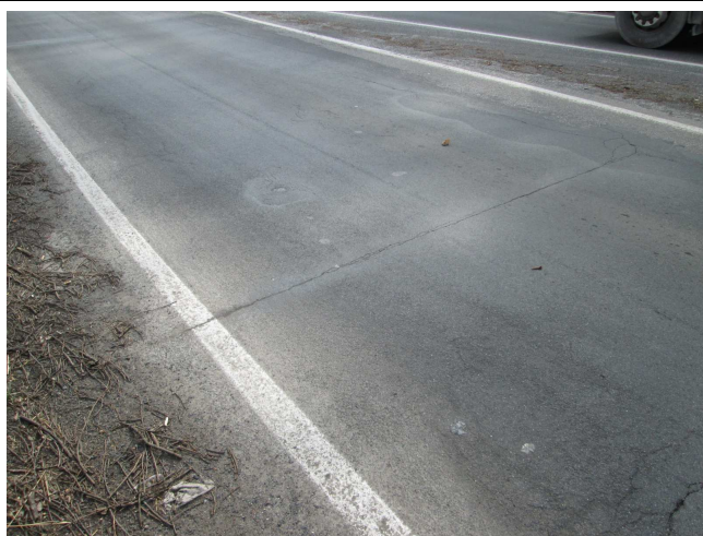
Dilatační spáry prokreslené do vozovky.
