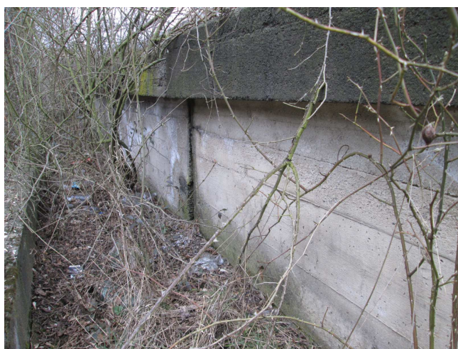
Stopy průsaků dilatační spárou. Nazelenalý povlak, biologické napadení.
