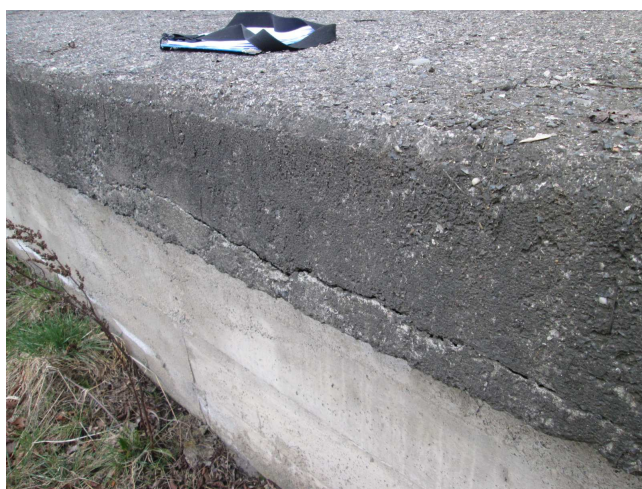
Separovaná krycí vrstva na ozubu římsy.
