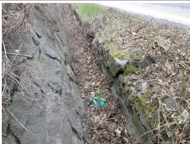
Lokálně vydrolené spáry.
