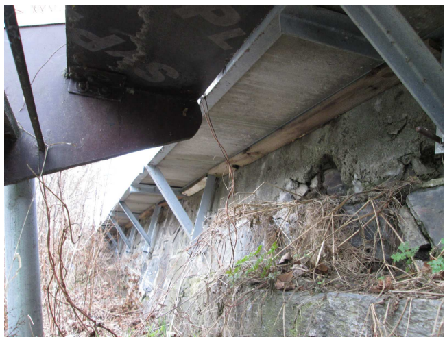
Konstrukce lávky upevněná k opěrné zdi u autobusové zastávky. Řešení lávky zcela neodpovídá předpisům.
