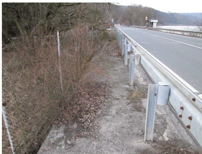
Nánosy, nečistoty na římse.
