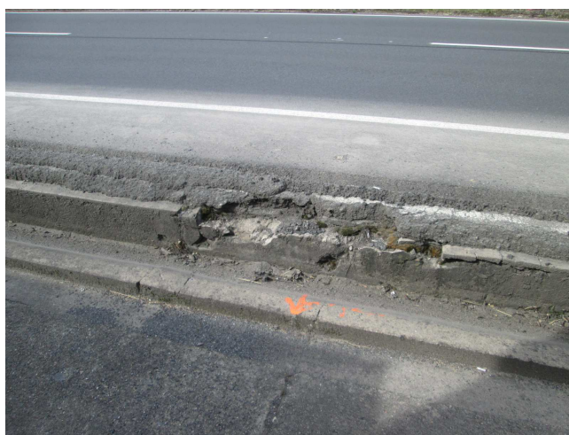
Masivní degradace betonu, rozpad.
