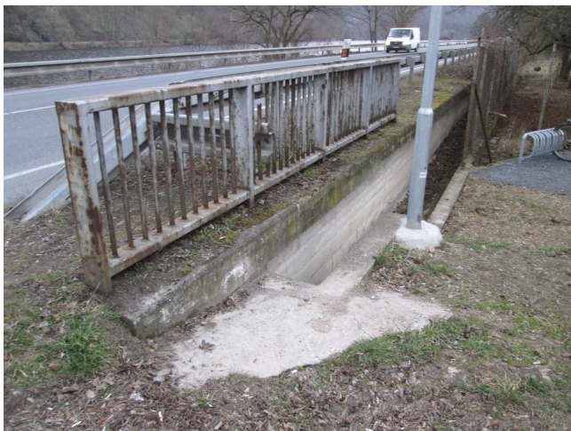
Koroze zábradlí.
