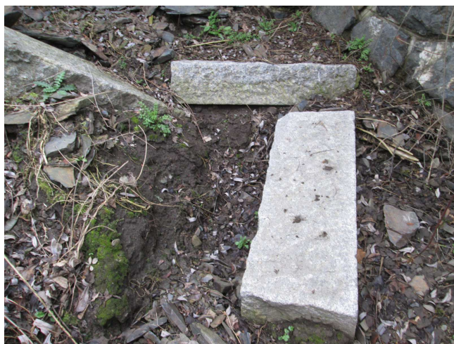
Kamenné bloky římsy shozené do koryta.
