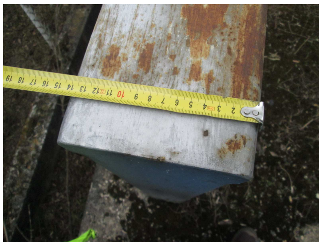
Koroze zábradlí.
