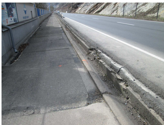
Pohled ve směru staničení. Výrazně převýšená vozovka. Degradace betonu. Trhliny.
