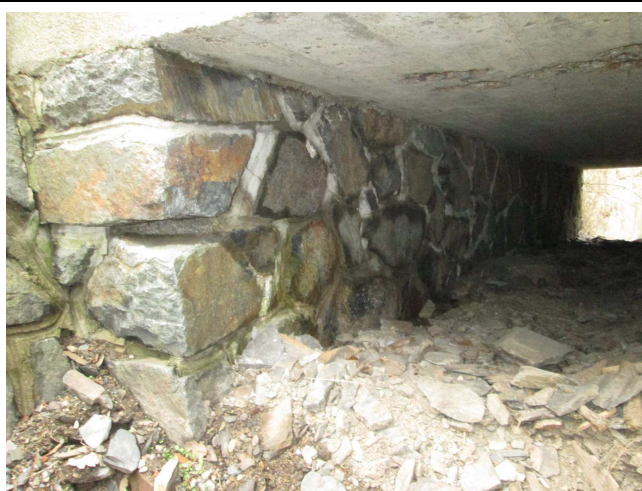
Opěra 1. Lokálně poškozené spárování.
