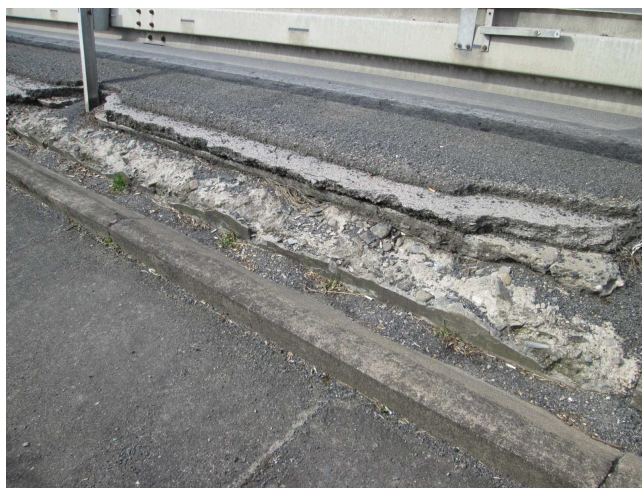
Masivní degradace betonu, rozpad. Část zdi chybí.
