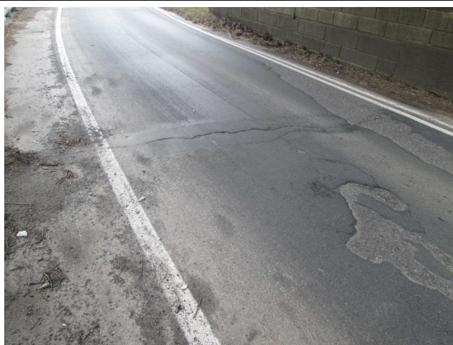
Dilatační spáry prokreslené do vozovky.
