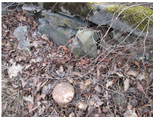
Masivně vydrolené spáry, rozvolněné zdivo.
