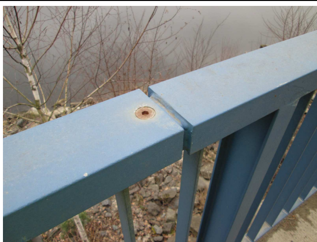
Zábradlí. Povrchová koroze šroubů. Nátěr matový.
