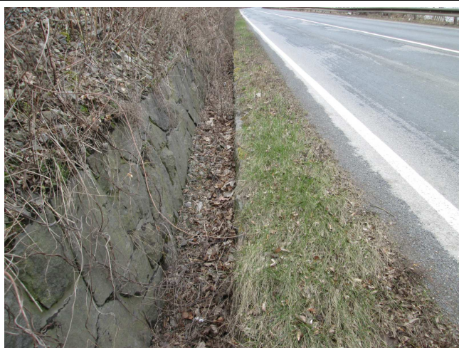
Příkop částečně zanesený.
