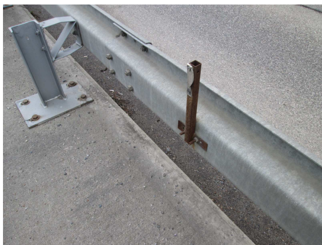
Poškozené směrové sloupky.
