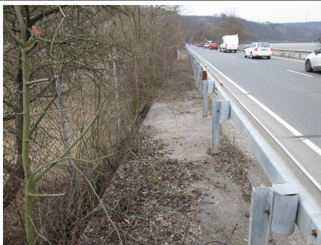
Nánosy, nečistoty na římse.
