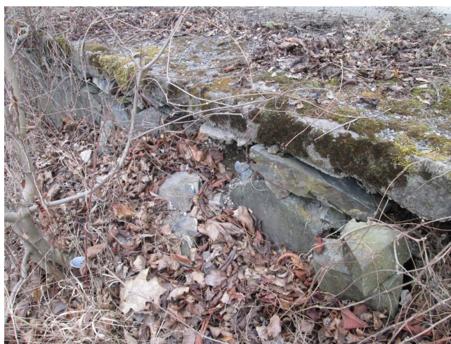
Masivně vydrolené spáry, rozvolněné zdivo.
