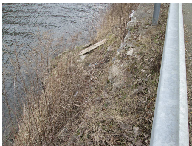
Masivní degradace betonu římsy, lokální rozpad.
