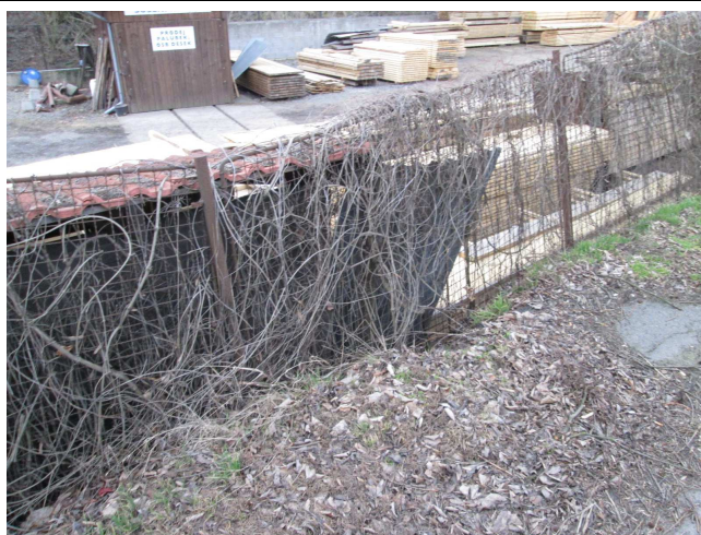
Zřícené oplocení upevněné do zdi.
