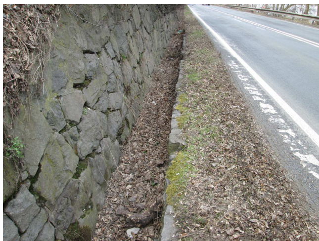
Příkop částečně zanesený.
