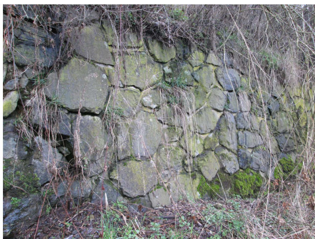
Ojedinělé poškození spárování.
