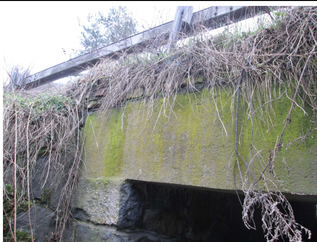
Bok nosné konstrukce vlevo. Rozpad cihel v oblasti pod původní římsou.
