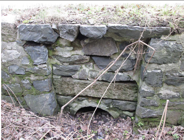
Vydrolené spáry. Částečně zanesený propust.
