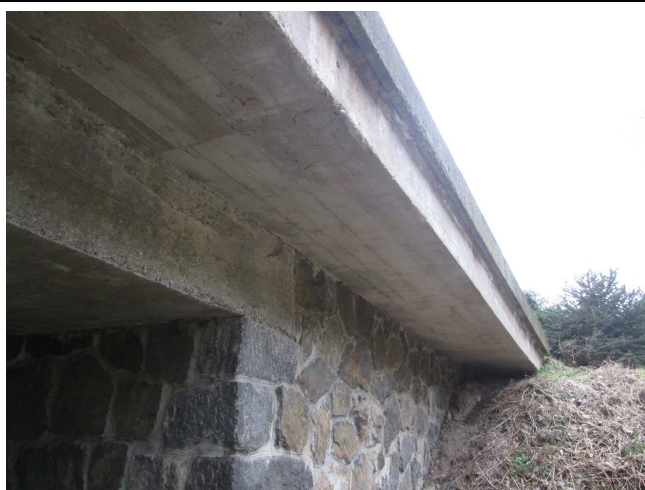
Podhled desky rozšíření vpravo.
