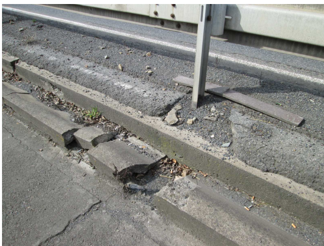
Rozpad předsazeného řlabu.
