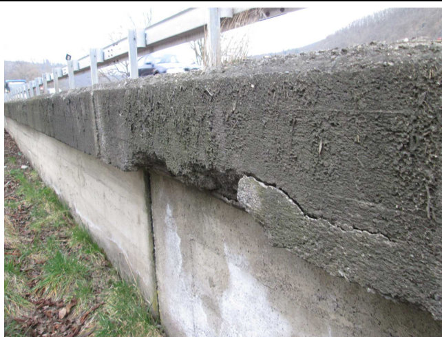
Odpadlá krycí vrstva, koroze obnažené výztuže.
