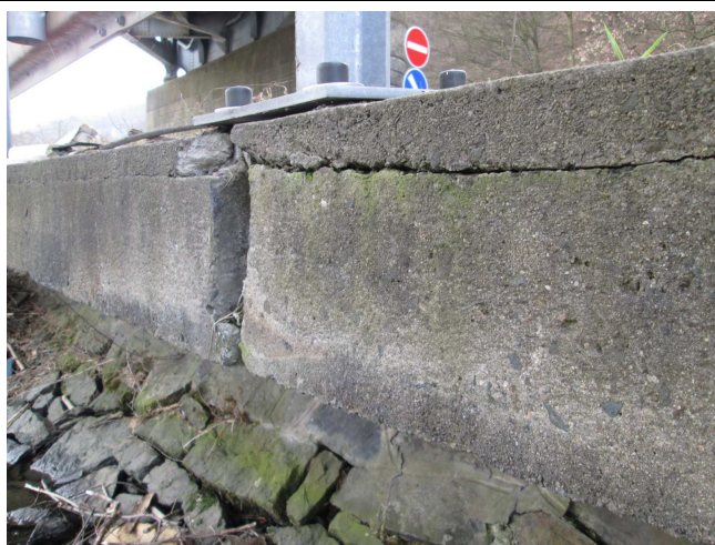
Delaminace horní části římsy.
