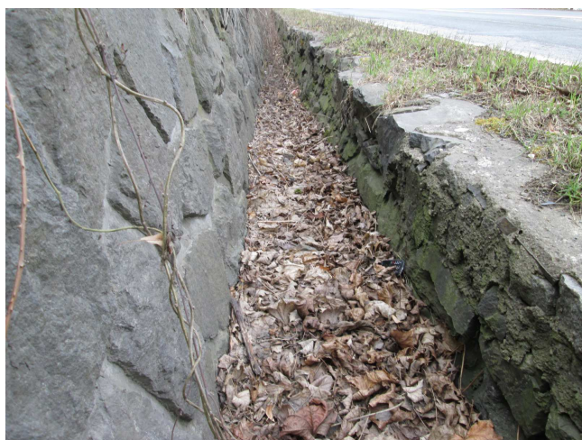
Lokálně vydrolené spáry.
