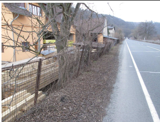
Zřícené oplocení upevněné do zdi.
