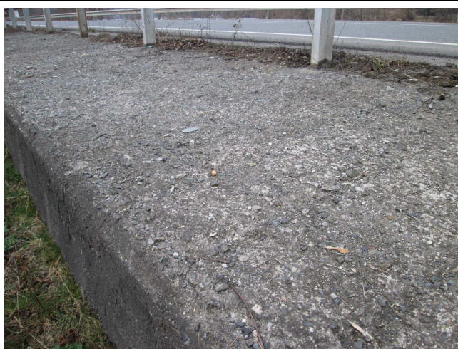
Degradace betonu římsy.
