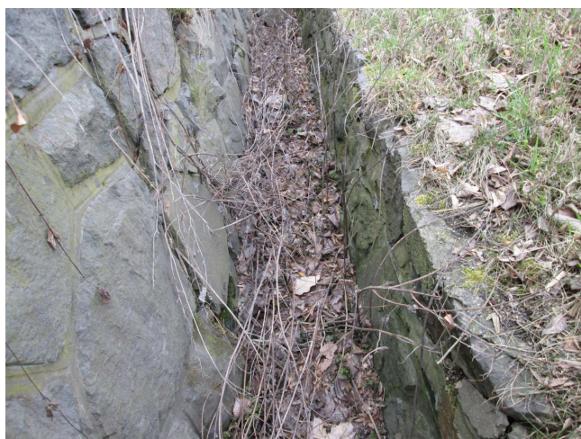
Příkop částečně zanesený.
