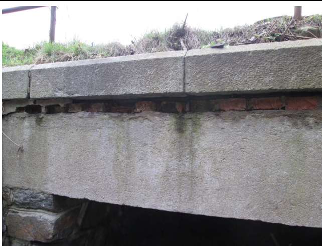
Rozpad cihel pod římsou vpravo.
